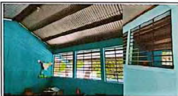
Foto 6: APERTURA DE DE VANO PARA VENTANA Y VENTANA DE METAL TIPO BALCON.
