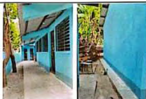
Foto 4: APLICACIÓN DE ACABADO EN MUROS DE BLOCK TIPO CERNICO Y PINTURA EXTERIOR E INTERIOR.
