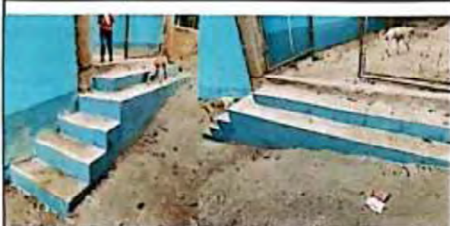
Foto 1: GRADAS EN INGRESO PRINCIPAL.
