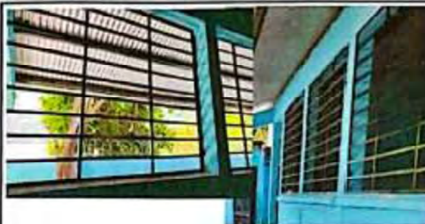
Foto 8: MANTENIMIENTO DE BALCONES Y COLOCACION DE CEDAZO.
