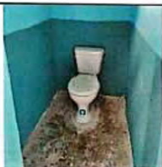
Foto 3: SUSTITUCION DE INODOROS.
