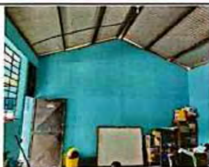
Foto 5: APLICACIÓN DE ACABADO EN MUROS DE BLOCK TIPO CERNICO Y PINTURA EXTERIOR E INTERIOR.
