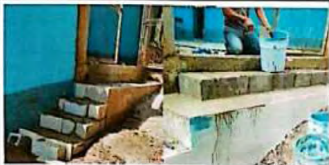
Foto 1: GRADAS EN INGRESO PRINCIPAL.
