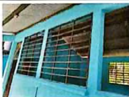
Foto 8: MANTENIMIENTO DE BALCONES Y COLOCACION DE CÉDAZO.
