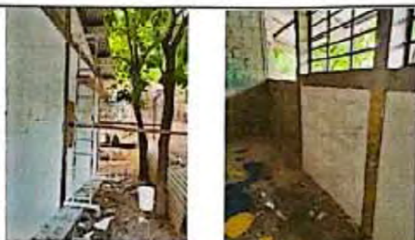
Foto 4: APLICACIÓN DE ACABADO EN MUROS DE BLOCK TIPO CERNICO.
