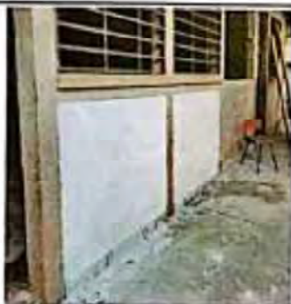
Foto 5: APLICACIÓN DE ACABADO EN MUROS DE BLOCK TIPO CERNICO.
