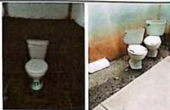
Foto 3: SUSTITUCION DE INODOROS.
