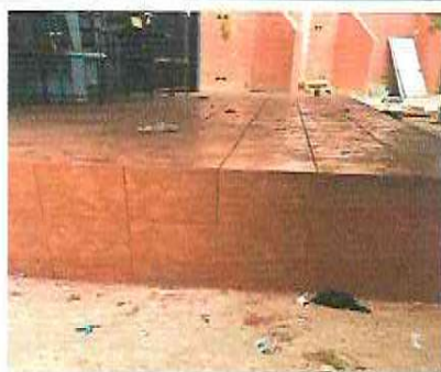
Foto 5: Instalación de piso cerámico en escenario
