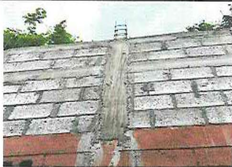
Foto1: reforzamiento e instalacion de muro perimetral de block.
