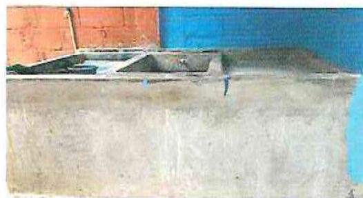
Foto 4: Sustitución de pila de concreto de 2 lavaderos. largo 3 mts, ancho 0.90, alto 1 m.
