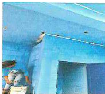
Foto 6: Pintura de muros interiores y exteriores
