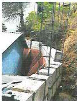
Foto1: reforzamiento e instalacion de muro perimetral de block.
