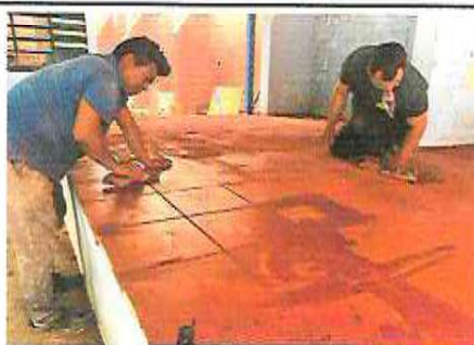
Foto 5: Instalación de piso cerámico en escenario
