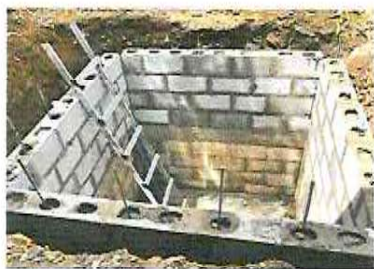
Foto 3: Sustitución de cisterna de Almacenamiento de agua, largo 2.5 mts, ancho 2.5 mts, alta 2 mts
