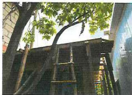
Foto 2: Sustitución de terraza en baños
