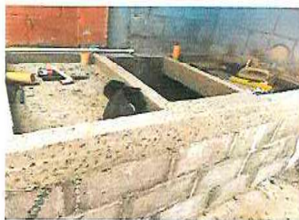
Foto 4: Sustitución de pila de concreto de 2 lavaderos, largo 3 mts, ancho 0.90, alto 1 m.
