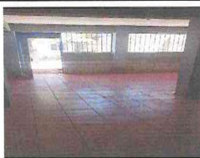
Foto 2: AULAS: Sustitución de piso Cerámico
