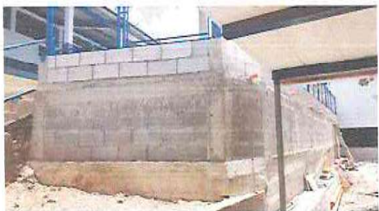
Foto 3: MURO DE CONTENCIÓN: Sustitución de muro de contención
