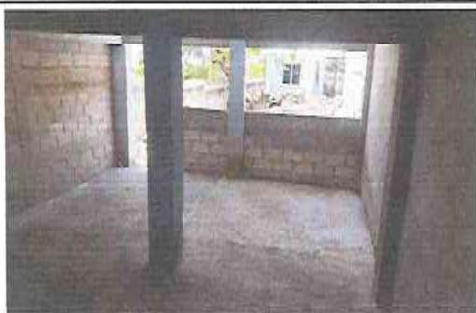
Foto 1: AULAS: Sustitución de torta de concreto a piso
