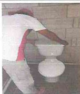
Foto 5: BAÑOS: Sustitución de inodoros.
