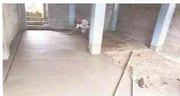
Foto 1: AULAS: Sustitución de torta de concreto a piso
