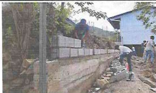
Foto 3: MURO DE CONTENCIÓN: Sustitución de muro de contención
