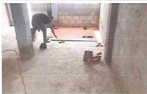
Foto 2: AULAS: Sustitución de piso Cerámico
