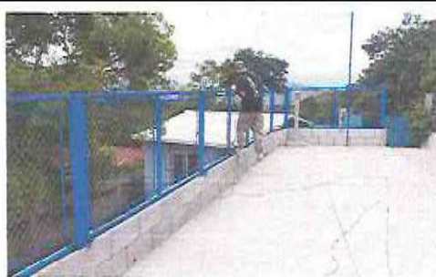
Foto 4: MURO PERIMETRAL: Sustitución de tubo y malla galvanizada
