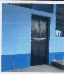
Foto 5: 1.5. SUSTITUCIÓN DE PUERTA
