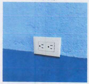
Foto 1: 1.1. SUSTITUCIÓN DE TOMACORRIENTES DOBLES (INCLUYE CALBE Y ACCESORIOS)
