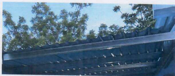
Foto 9: 2.1. SUSTITUCION DE ESTRUCTURA DE SOPORTE DE METAL, POR METAL
