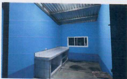
Foto 11: 2.3. INSTALACION DE MESA DE CONCRETO DE 2.8 m * 1.00 m * 1.00 m (toda con azulejos y entrepaños para reguardar los utensilios de cocina) SE INSTALARAN 10 METROS CUADRADOS DE AZULEJO, 2.50 METROS DE
