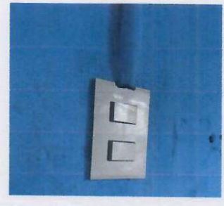
Foto 4: 1.4. SUSTITUCIÓN DE INTERRUPTORES DOBRES (INCLUYE CABLE Y ACCESORIOS)
