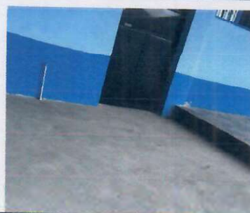
Foto 12: 2.4. SUSTITUCION DE DE PISO DE TORTA DE CONCRETO
