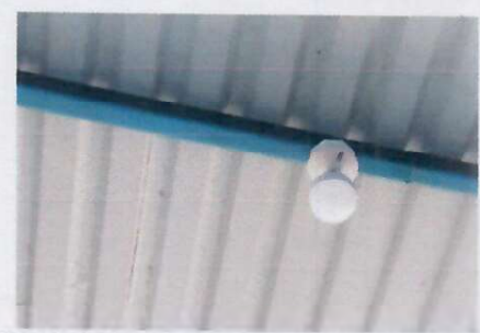
Foto 2: 1.2. SUSTITUCIÓN DE PLAFONERAS (INCLUYE CABLE Y ACCESORIOS)
