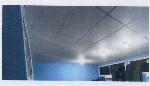
Foto 6: 1.6. INSTALACIÓN DE CIELO FALSO
