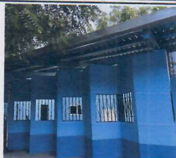
Foto 8: 1.8. PINTURA EN MUROS EXTERIORES E INTERIORES
