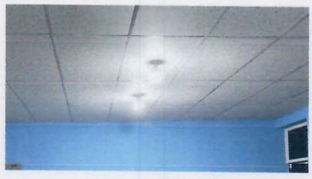
Foto 3: 1.3 SUSTITUCIÓN DE LAMPARAS LED
