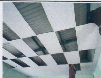
Foto 6: 1.6. INSTALACIÓN DE CIELO FALSO
