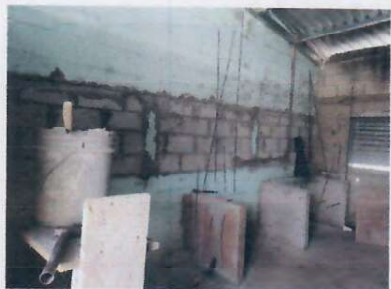
Foto 11: 2.3. INSTALACION DE MESA DE CONCRETO DE 2.8 m * 1.00 m * 1.00 m (toda con azulejos y entrepaños para reguardar los utensilios de cocina) SE INSTALARAN 10 METROS CUADRADOS DE AZULEJO, 2.50 METROS DE
