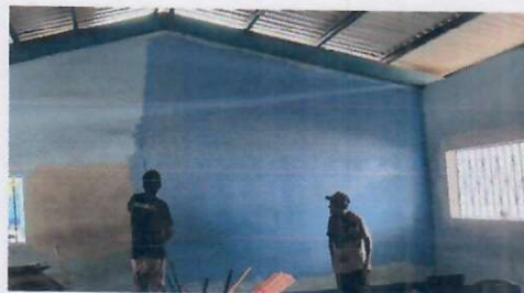
Foto 8: 1.8. PINTURA EN MUROS EXTERIORES E INTERIORES
