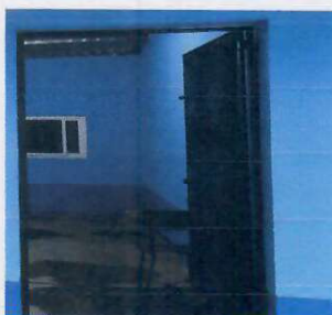
Foto 5: 1.5. SUSTITUCIÓN DE PUERTA
