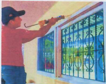
FOTO 7: 1.7. INSTALACIÓN DE VENTANA PVC CORREDIZA
