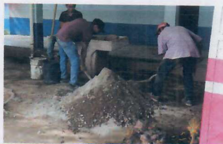
Foto 12: 2.4. SUSTITUCION DE DE PISO DE TORTA DE CONCRETO
