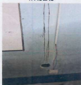
Foto 1: 1.1. SUSTITUCIÓN DE TOMACORRIENTES DOBLES (INCLUYE CALBE Y ACCESORIOS)
