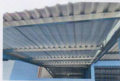
Foto 10: 2.2. SUSTITUCION DE LAMINA POR LAMINA TROQUELADA ALUZINC CALBRE 26
