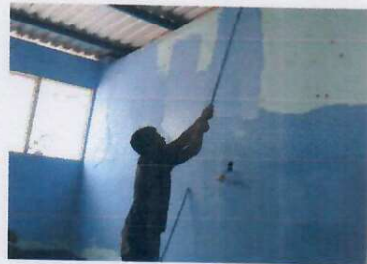
Foto 8: 3.1. PINTURA INTERIOR Y EXTERIOR
