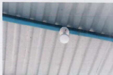
Foto 2: 1.2. SUSTITUCIÓN DE PLAFONERAS (INCLUYE CABLE Y ACCESORIOS)
