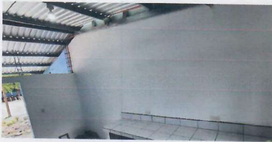
FOTO 7: 2.5. REPELLO EN MUROS
