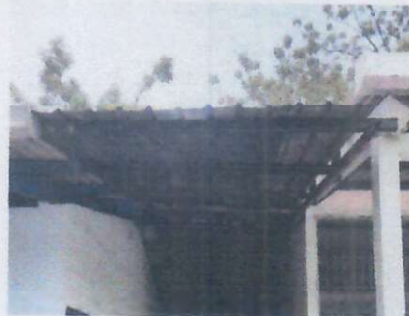
Foto 10: 2.2. SUSTITUCION DE LAMINA POR LAMINA TROQUELADA ALUZINC CALBRE 26
