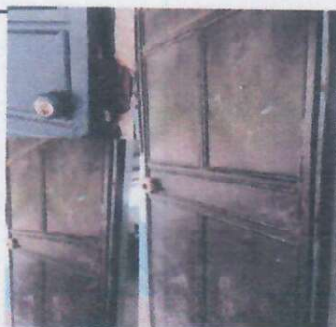
Foto 5: 1.5. SUSTITUCIÓN DE PUERTA
