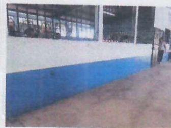
Foto 8: 1.8. PINTURA EN MUROS EXTERIORES E INTERIORES
