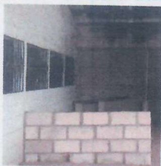
FOTO 7: 2.5. REPELLO EN MUROS
