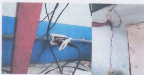
Foto 1: 1.1. SUSTITUCIÓN DE TOMACORRIENTES DOBLES (INCLUYE CALBE Y ACCESORIOS)
