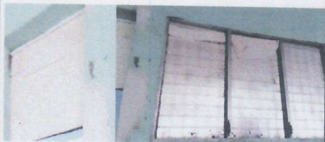
FOTO 7: 1.7. INSTALACIÓN DE VENTANA PVC CORREDIZA
