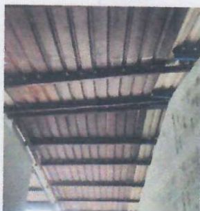
Foto 9: 2.1. SUSTITUCION DE ESTRUCTURA DE SOPORTE DE METAL, POR METAL
