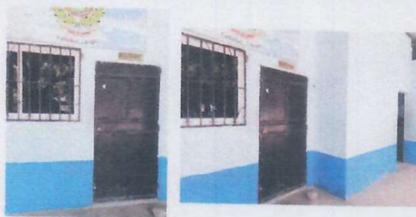
Foto 8: 3.1. PINTURA INTERIOR Y EXTERIOR
