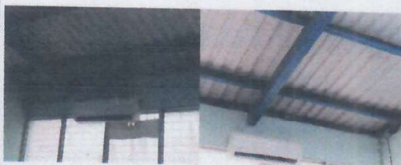
Foto 6: 1.6. INSTALACIÓN DE CIELO FALSO
