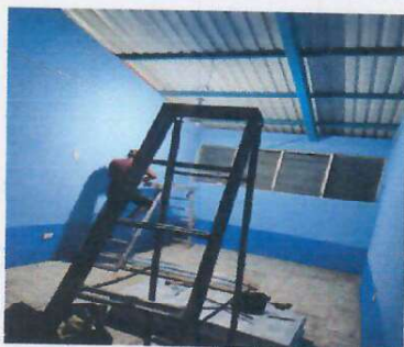
PINTURA EN MUROS INTERIORES Y EXTERIORES
