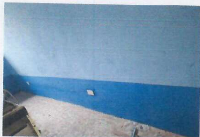
Foto1: SUSTITUCIÓN DE TOMACORRIENTES DOBLES
