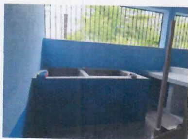
Foto 5: SUSTITUCIÓN DE PILA DE UN LAVADERO
