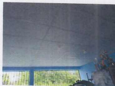
Foto 6: INSTALACIÓN DE CIELO FALSO
