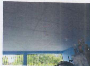
Foto 2: INSTALACIÓN DE CIELO FALSO
