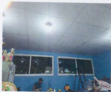
Foto 3: INSTALACIÓN DE VENTANA PVC CORREDIZA CON CEDAZO
