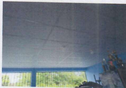
Foto 2: SUSTITUCIÓN DE LÁMPARAS POR BOMBILLAS TIPO LED
