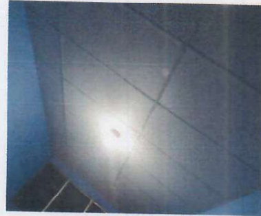
Foto 2: SUSTITUCIÓN DE LÁMPARAS POR BOMBILLAS TIPO LED
