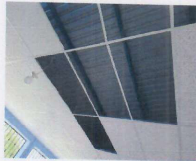
Foto 6: INSTALACIÓN DE CIELO FALSO EN SALA DE MAESTROS
