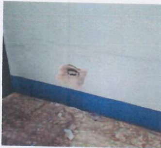
Foto1: SUSTITUCIÓN DE TOMACORRIENTES DOBLES
