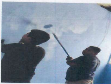
PINTURA EN MUROS INTERIORES Y EXTERIORES
