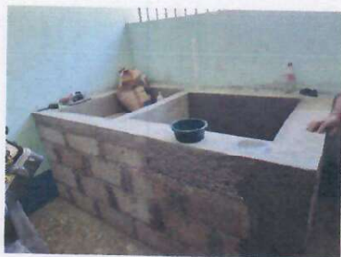
Foto 5: SUSTITUCIÓN DE PILA DE UN LAVADERO
