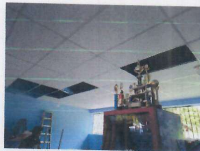
Foto 2: INSTALACIÓN DE CIELO FALSO
