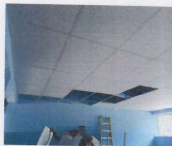
Foto 6: INSTALACIÓN DE CIELO FALSO
