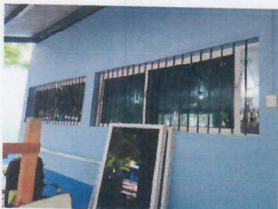
Foto 3: INSTALACIÓN DE VENTANA PVC CORREDIZA CON CEDAZO
