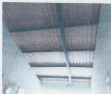
Foto 2: INSTALACIÓN DE CIELO FALSO
