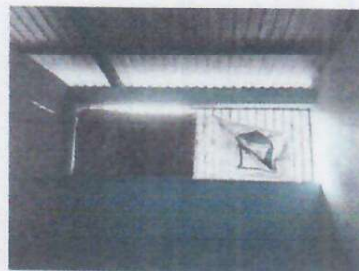
Foto 6: INSTALACIÓN DE CIELO FALSO EN SALA DE MAESTROS
