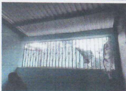
Foto 3: INSTALACIÓN DE VENTANA PVC CORREDIZA CON CEDAZO
