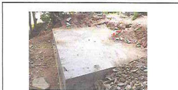
Foto 5: BAÑOS: Reparación de Fosa séptica.
