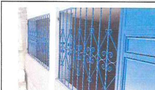
Foto 2: AULAS: Instalación de balcones en muros de aulas.
