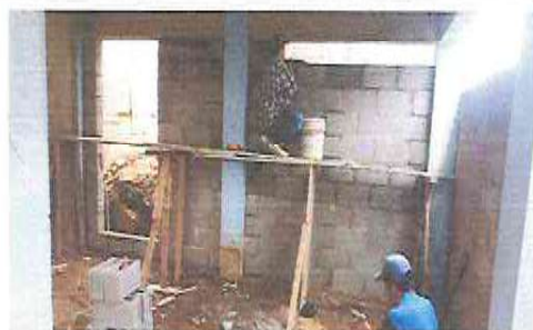
Foto1: AULAS: Instalación de Muro de Block
