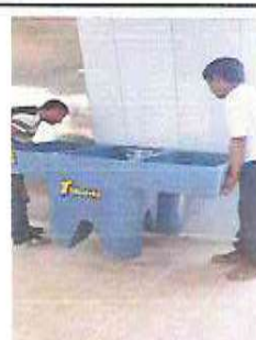
Foto 6: COCINA: sustitución de pila plástica de 2 lavaderos.
