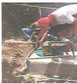
Foto 3: BAÑOS: Sustitución de Red tubería principal de agua Potable.
