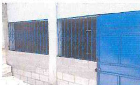
Foto 2: AULAS: Instalación de balcones en muros de aulas .
