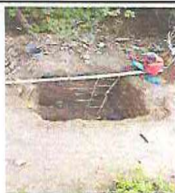
Foto 5: BAÑOS: Reparación de Fosa séptica.
