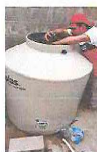
Foto 4: BAÑOS: Sustitución de sistema de agua 1100lts.
