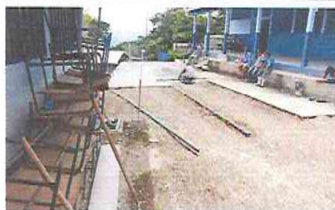
Foto 8: PATIO: Sustitución de plancha de concreto.
