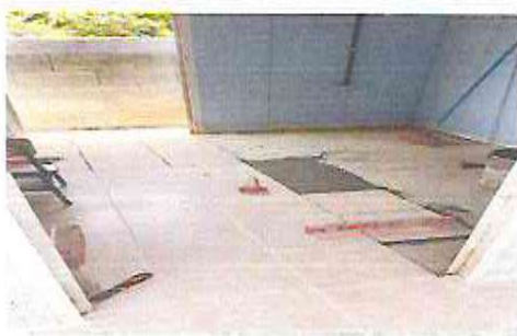
Foto 7: COCINA: Sustitución de piso cerámico.
