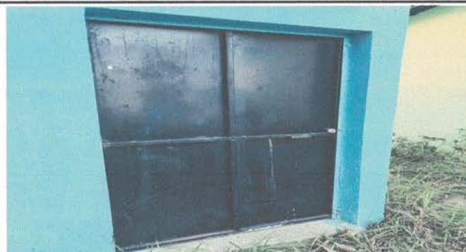
Foto 8: Reapación, mantenimiento y sustitución de chapa en puerta metálica de cocina.
