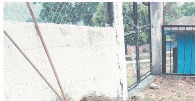
Foto 11: Continuidad de muro perimetral.
