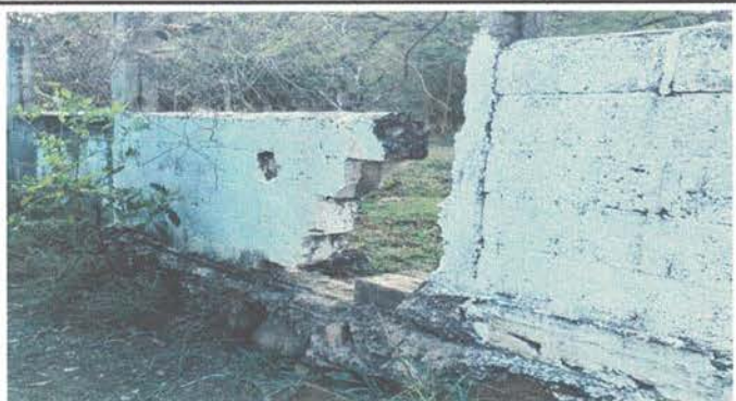
Foto 3: Sellado y reparación de muro perimetral.
