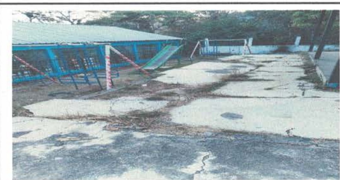
Foto 12: Reparación de piso de cemento en patio.
