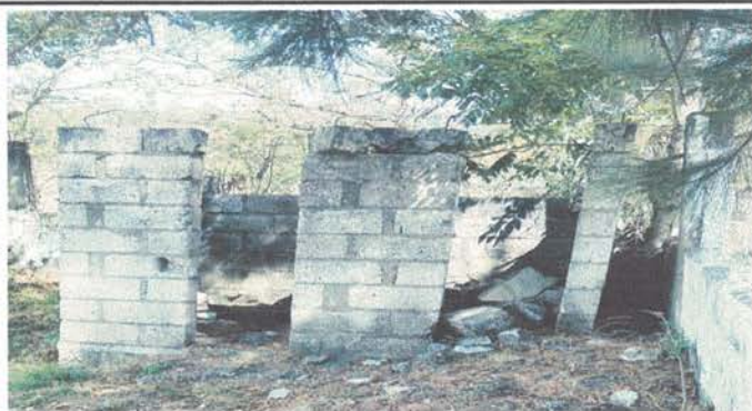
Foto 1: Reparación de paredes, sustitución de sanitarios, colocación de techo.
