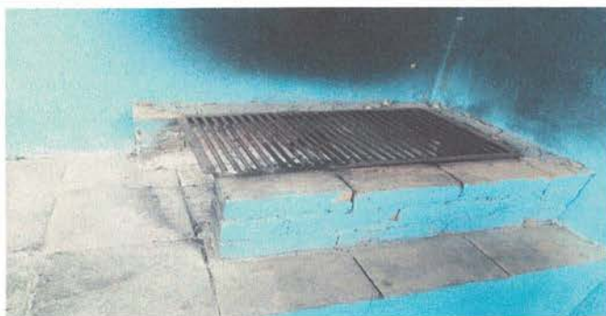
Foto 9: Sustitución de estufa en la cocina.
