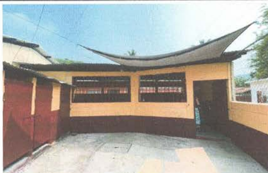
Módulo Aula: 1.5 levantado hiladas de block, 1.6 mantenimiento a balcones de metal (lijado y pintura), 1.9 Sustitución de chapa, 1.10 mantenimiento a estructura de puerta
