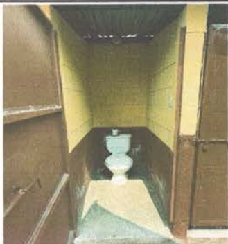
Módulo Baños: 2.5 Sustitución de inodoros, 2.7 colocación de piso cerámico.
