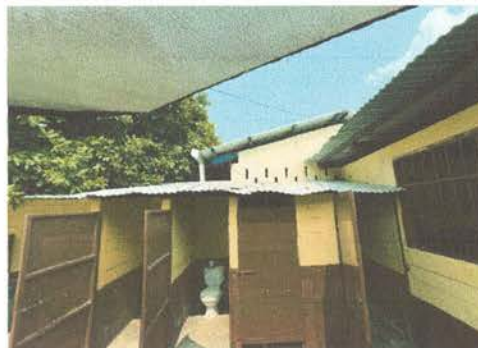
Módulo Baños: 2.6 Mantenimiento estructura ( lijado, cambio de tubo, cepillado, pintura)
