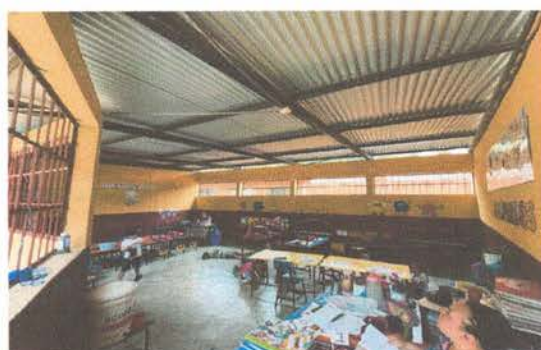
Módulo Aula: 1.7 Instalación ventanas de pvc, 1.8 Instalación piso cerámico
