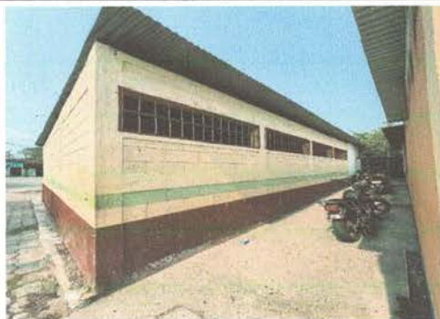
Canales y bajadas de agua pluvial: 7.1 Colocación de canal de metal
