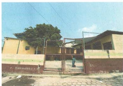
Área de Ingreso: 3.1 Sustitución de portón.
