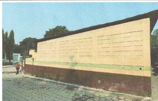
Pintura: 5.1 Pintura interior y exterior ( aula y muro primetal)
