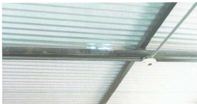
Módulo Aula: 1.1 y 1.2 sustitución de lámina y mantenimiento a estructura metálica.
