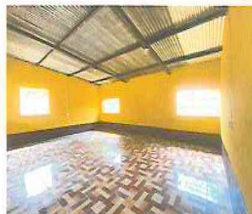
FOTO 2: NSTALACIÓN DE BALCONES EN VENTANAS DE 2X1 MTS
