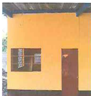
FOTO 3: NSTALACIÓN DE PUERTA DE METAL
