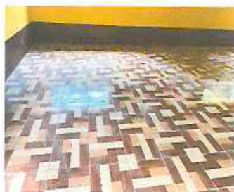
FOTO 5: COLOCACIÓN DE PISO CERÁMICO
