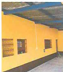
FOTO 1: INSTALACIÓN ELÉCTRICA ILUMINACIÓN Y FUERZA
