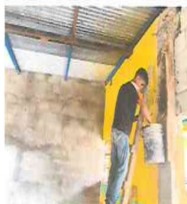
FOTO 3: NSTALLACIÓN DE PUERTA DE METAL
