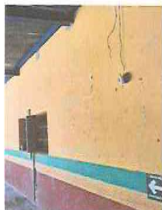
FOTO 1: INSTALACIÓN ELÉCTRICA ILUMINACIÓN Y FUERZA
