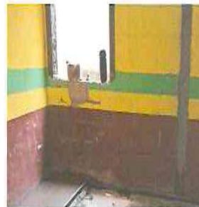
FOTO 2: NSTALLACIÓN DE BALCONES EN VENTANAS DE 2X1 MTS
