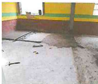
FOTO 5: COLOCACIÓN DE PISO CERÁMICO
