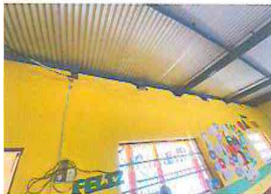
FOTO 1: INSTALACIÓN ELÉCTRICA ILUMINACIÓN Y FUERZA
