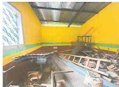
FOTO 2: NSTALACIÓN DE BALCONES EN VENTANAS DE 2X1 MTS
