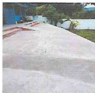
FOTO 12: SUSTITUCIÓN DE PLANCHA DE CONCRETO EN PATIO
