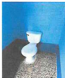
FOTO 4: SUSTITUCIÓN DE INODORO
