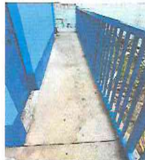
FOTO 8: SUSTITUCIÓN DE DE BANQUETAS DE CONCRETO
