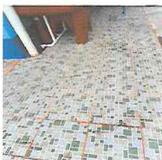
FOTO 5: SUSTITUCIÓN DE PISO DE GRANITO POR PISO MATE
