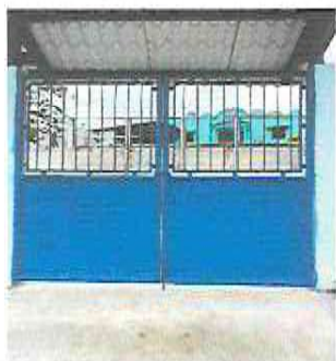
FOTO 13: MANTENIMIENTO DE PORTÓN
