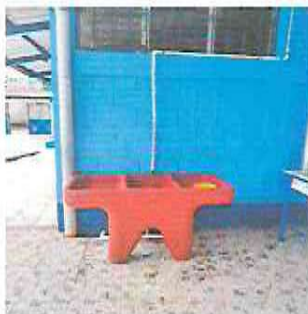
FOTO 7: SUSTITUCIÓN PILA DE CONCRETO POR UNA PLÁSTICA
