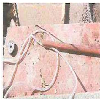
FOTO 10: SELLADO DE GRIETAS EN BANQUETA
