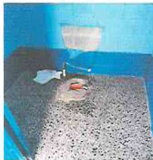
FOTO 4: SUSTITUCIÓN DE INODORO
