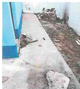
FOTO 8: SUSTITUCIÓN DE DE BANQUETAS DE CONCRETO
