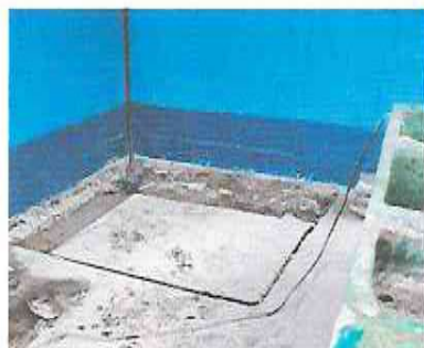
FOTO 11: SUSTITUCIÓN DE ESTUFA PREFABRICADA
