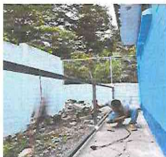
FOTO 9: INSTACIÓN DE BARRANDA DE METAL
