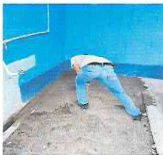
FOTO 5: SUSTITUCIÓN DE PISO DE GRANITO POR PISO MATE
