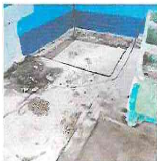
FOTO 7: SUSTITUCIÓN PILA DE CONCRETO POR UNA PLÁSTICA
