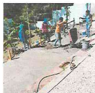
FOTO 12: SUSTITUCIÓN DE PLANCHA DE CONCRETO EN PATIO
