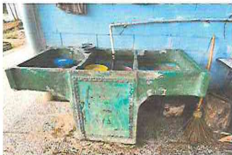
FOTO 7: SUSTITUCIÓN PILA DE CONCRETO POR UNA PLÁSTICA
