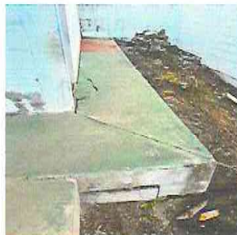
FOTO 8: SUSTITUCIÓN DE DE BANQUETAS DE CONCRETO
