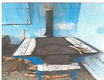
FOTO 11: SUSTITUCIÓN DE ESTUFA PREFABRICADA
