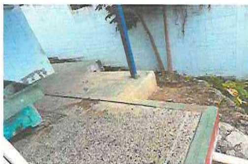
FOTO 9: INSTACIÓN DE BARRANDA DE METAL
