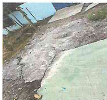
FOTO 12: SUSTITUCIÓN DE PLANCHA DE CONCRETO EN PATIO
