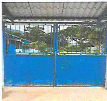
FOTO 13: MANTENIMIENTO DE PORTÓN
