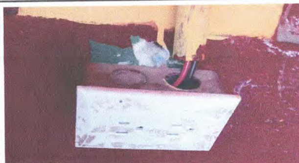
Sistema Eléctrico: Sustitución de sistema de poder y fuerza para ventiladores
