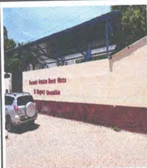
Muro Perimetral: 7.1 Reparación de repello más cernido. 7.2 Pintura (raspado y pintura)
