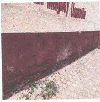
Muro Perimetral: 7.1 Reparación de repello más cernido. 7.2 Pintura (raspado y pintura)
