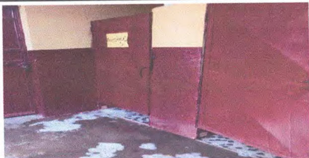
Módulo Baños: Sustitución de puertas
