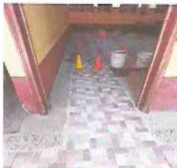
FOTO 1: SUSTITUCIÓN DE PISO DE GRANITO POR PISO CERAMICO
