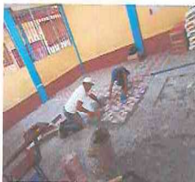
FOTO 5: SUSTITUCIÓN DE PISO DE GRANITO POR PISO CERAMICO EN AULAS
