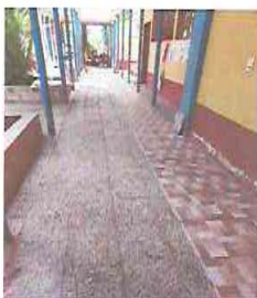
FOTO 3: SUSTITUCIÓN DE PISO DE GRANITO POR PISO CERAMICO DE CORREDOR
