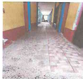
FOTO 4: SUSTITUCIÓN DE PISO DE GRANITO POR PISO CERAMICO
