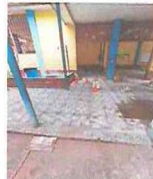
FOTO 2: SUSTITUCIÓN DE PISO DE GRANITO POR PISO CERAMICO
