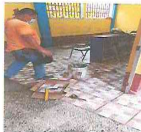
FOTO 6: SUSTITUCIÓN DE PISO DE GRANITO POR PISO CERAMICO
