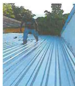
FOTO 4: MANTENIMIENTO A ESTRUCTURA DE METAL
