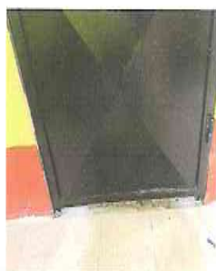
FOTO 3: SUSTITUCION PUERTA METALICA
