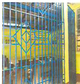
FOTO 10: MANTENIMIENTO DE BARANDA
