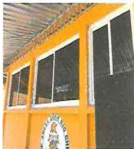
FOTO 7: SUSTITUCIÓN DE VENTANA EXISTENTE POR PVC
