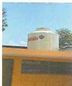
FOTO 9: COLOCACIÓN DE ROTOPLAS
