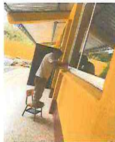
FOTO 8: PINTURA EN INTERIORES Y EXTERIORES
