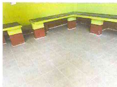
FOTO 2: COLOCACIÓN DE PISO CERÁMICO
