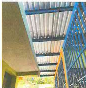
FOTO 1: CONTINUACIÓN DETECHADO EN AREA DE PILA, CON LAMINA TROQUELADA CAL. 26
