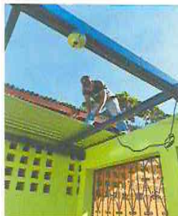
FOTO 4: MANTENIMIENTO A ESTRUCTURA DE METAL
