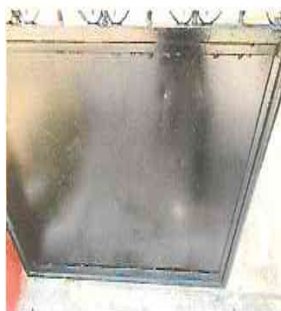
FOTO 3: SUSTITUCION PUERTA METALICA
