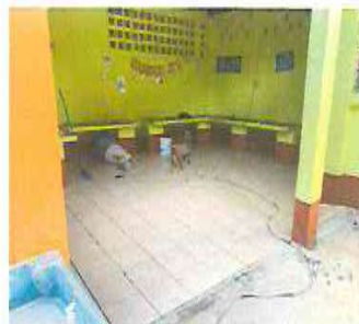
FOTO 2: COLOCACIÓN DE PISO CERÁMICO
