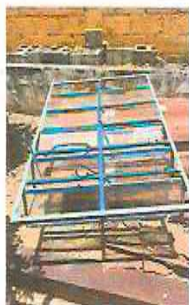
FOTO 7: SUSTITUCIÓN DE VENTANA EXISTENTE POR PVC
