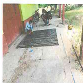
FOTO 10: MANTENIMIENTO DE BARANDA
