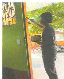
FOTO 8: PINTURA EN INTERIORES Y EXTERIORES
