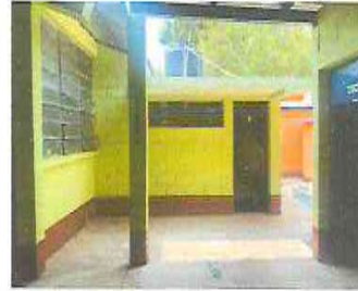
FOTO 2: COLOCACIÓN DE PISO CERÁMICO
