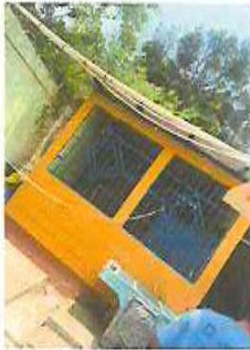
FOTO 1: CONTINUACIÓN DETECHADO EN AREA DE PILA, CON LAMINA TROQUELADA CAL. 26
