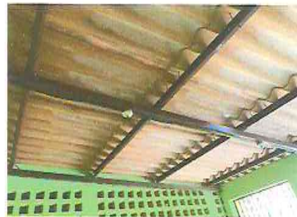
FOTO 4: MANTENIMIENTO A ESTRUCTURA DE METAL
