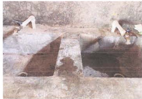
sustitución de llaves de chorro
