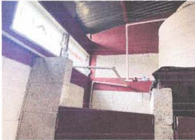
sustitución de llave de cheque y tubería
