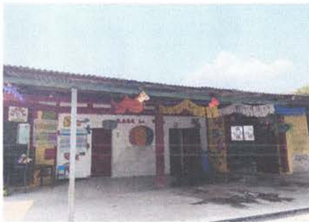
sustitución de estructura de madera, por estructura de metal.
