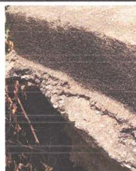
reparación de plancha de concreto de patio
