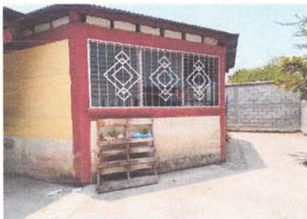
pintura a muros exteriores e interiores.
