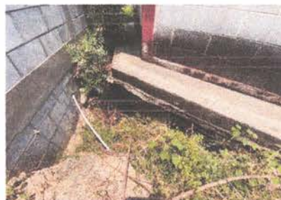
sustitución de fosa séptica.
