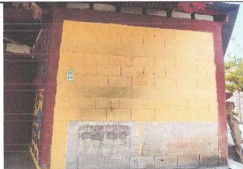
pintura a muros exteriores e interiores
