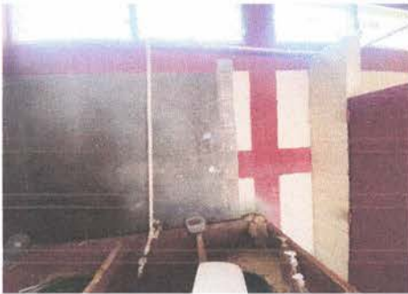
sustitución de tubería
