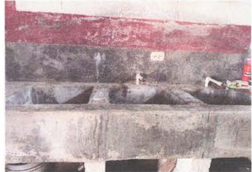
sustitución de llaves de chorros
