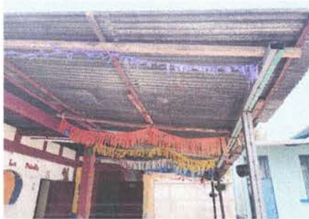
sustitución de lámina, por lámina toquelada aluzinc calibre 26
