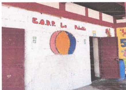
mantenimiento a estructuras de puertas de metal
