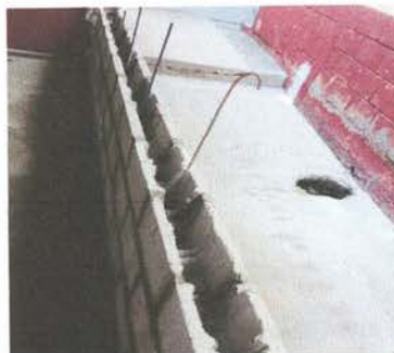
FOTO 4: LEVANTADO DE HILADAS DE BLOCK EN MURO DE COCINA
