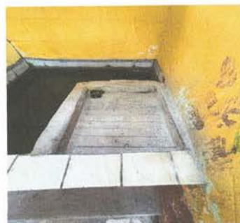
FOTO 6: ELABORACIÓN DE PILA 2 DE ANCHO X 2 DE LARGO CON AZULEJO
