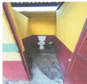
FOTO 10: SUSTITUCION DE HINODOROS EN AREA DE BAÑOS
