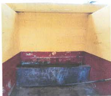
FOTO 13: REPOSICION URINAL DE CONCRETO FUNDIDIO IN SITU
