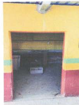
FOTO 8: INSTACIÓN DE PUERTA DE COCINA 0.91 ANCHO X 1.95 LARGO
