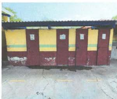
FOTO 11: REPOSICION DE PUERTAS METALICAS 0.70X1.90M
