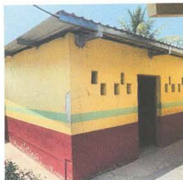
FOTO 20: PINTURA GENERAL EN COCINA EXTERNO E INTERNO
