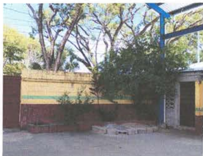
FOTO 21: PINTURA GENERAL MURO PERIMETAL EXTERNO E INTERNO
