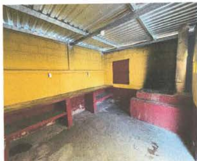
FOTO 1: DEMOLICION Y RETIRO DE MATERIAL DE ESTUFA DETERIORADA EXISTENTE
