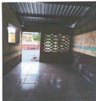
FOTO 19: PINTURA GENERAL EN AULA EXTERNO E INTERNO
