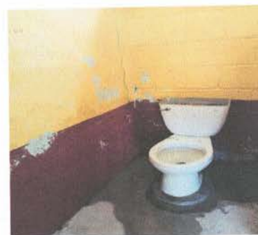
FOTO 14: INSTALACION DE PISO CERAMICO ANTIDESLIZANTE EN BAÑOS
