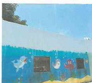
FOTO 3: LEVANTADO DE BLOCK EN COCINA
