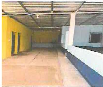
FOTO 7: PINTURA EN INTERIOR Y EXTERIOR DONDE SE EJECUTO EL REMOZAMIENTO
