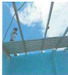
FOTO 2: COLOCACIÓN DE ESTRUCTURA METÁLICA
