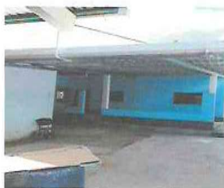
FOTO 1: RETIRO DE LAMINA Y ESTRUCTURA DE MADERA
