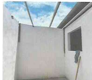
FOTO 6: REPELLO EN AJUSTES DE PAREDES
