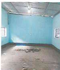
FOTO 5: REPARACION ELECTRICA EN TECHO DE AULAS
