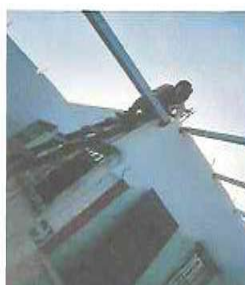
FOTO 2: COLOCACIÓN DE ESTRUCTURA METÁLICA
