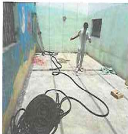
FOTO 5: REPARACION ELECTRICA EN TECHO DE AULAS
