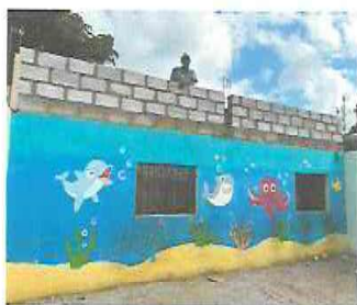
FOTO 3: LEVANTADO DE BLOCK EN COCINA
