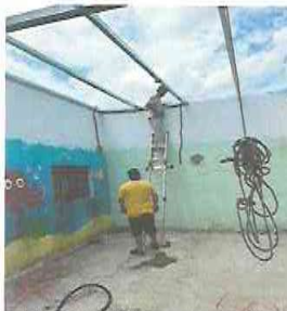
FOTO 4: SUSTITUCION DE LAMINA POR LAMINA TROQUELADA CAL. 26 ALUZINC
