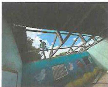
FOTO 1: RETIRO DE LAMINA Y ESTRUCTURA DE MADERA
