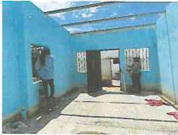
FOTO 7: PINTURA EN INTERIOR Y EXTERIOR DONDE SE EJECUTO EL REMOZAMIENTO
