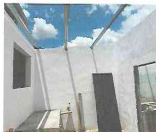
FOTO 6: REPELLO EN AJUSTES DE PAREDES
