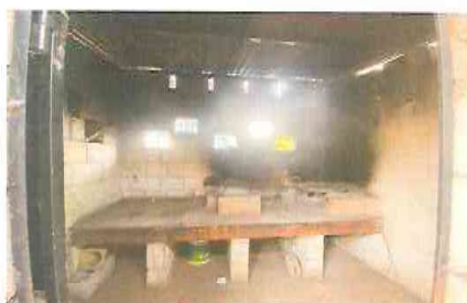
FOTO 3: LEVANTADO DE BLOCK EN COCINA
