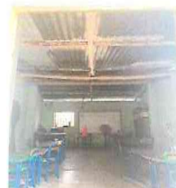
FOTO 6: REPELLO EN AJUSTES DE PAREDES
