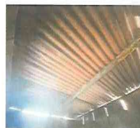
FOTO 4: SUSTITUCION DE LAMINA POR LAMINA TROQUELADA CAL. 26 ALUZINC
