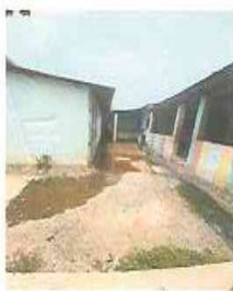
FOTO 1: RETIRO DE LAMINA Y ESTRUCTURA DE MADERA
