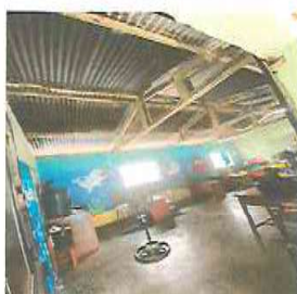
FOTO 5: REPARACION ELECTRICA EN TECHO DE AULAS
