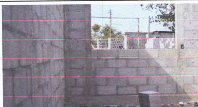
Foto 3: Instalación de puertas metálicas.
