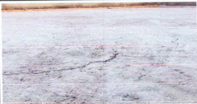
Foto 7: Sustitución de piso de concreto.
