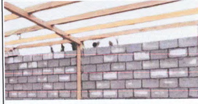
Foto 4: Instalación de estructura metálica y lámina.
