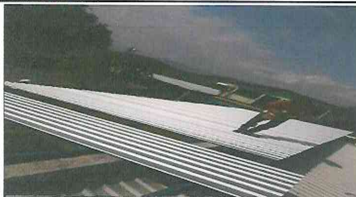
Foto 1: Instalación de lámina troquelada aluzinc cal. 26.
