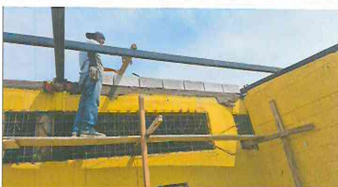
Foto 4: Levantado de hiladas de block.
