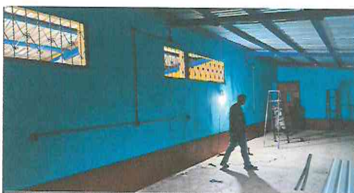
Foto 5: Reparación eléctrica iluminación y fuerza.
