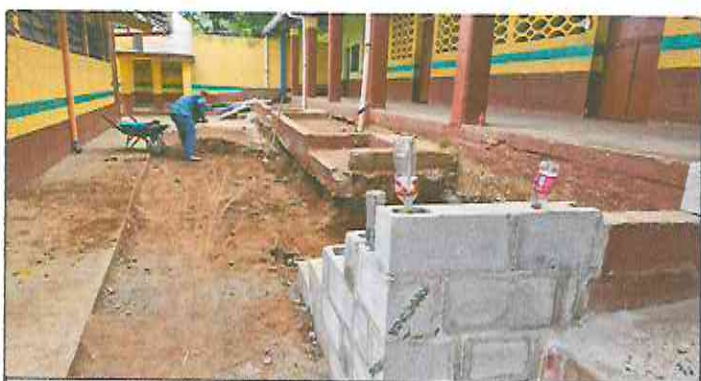
Foto 5: Construcción gradas en escenario.
