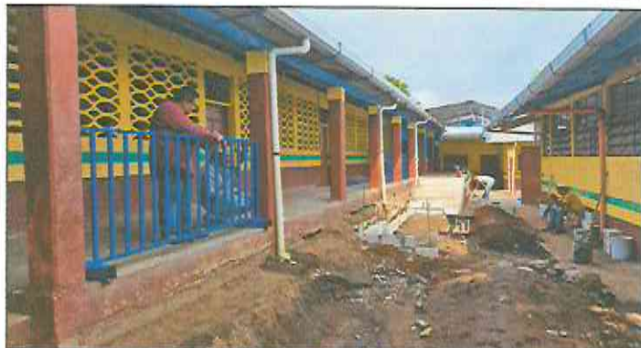
Foto 3: Instalación de baranda metálica en corredor.
