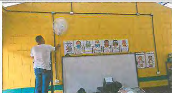
Foto 1: Sustitución de ventiladores.
