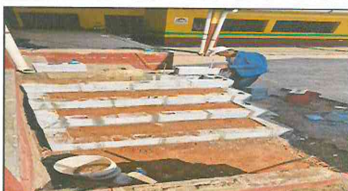
Foto 4: Construcción gradas en escenario.
