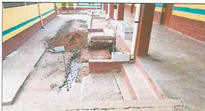
Foto 3: Construcción gradas en escenario.
