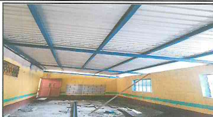
Foto 2: Instalación de lámina troquelada aluzinc cal. 26.
