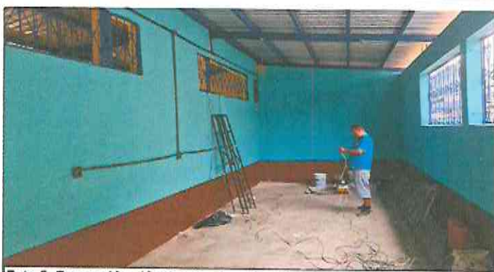
Foto 5: Reparación eléctrica iluminación y fuerza.
