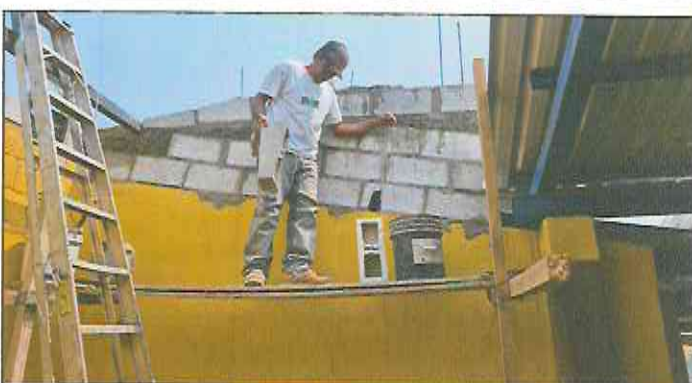
Foto 4: Levantado de hiladas de block.
