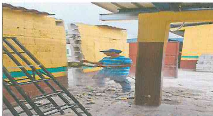
Foto 4: Sustitución de portón de ingreso de 2.5m x 4.00m y techado en área de portón con costanera + lamina troquelada aluzinc cal. 26.
