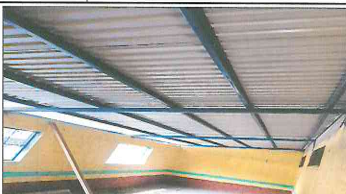
Foto 2: Instalación de lámina troquelada aluzinc cal. 26.
