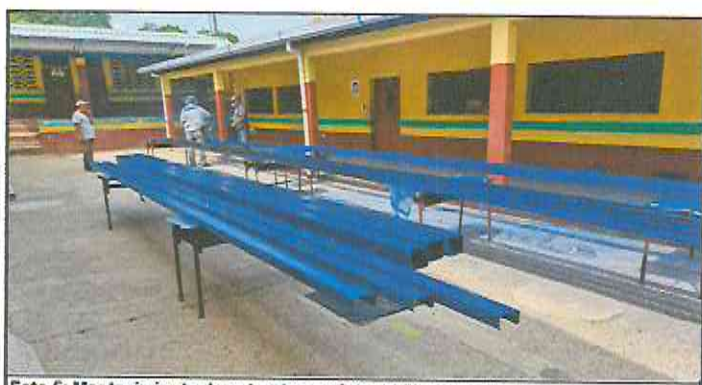
Foto 5: Mantenimiento de estructura existente (limpieza, lijado y pintura anticorrosiva), reforzamiento de estructura con costanera de 2x4.
