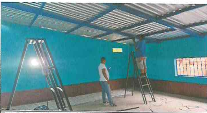
Foto 5: Reparación eléctrica iluminación y fuerza.
