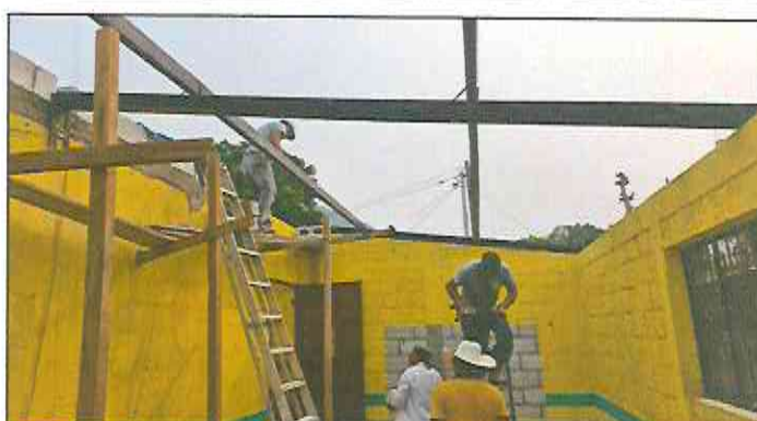
Foto 4: Levantado de hiladas de block.
