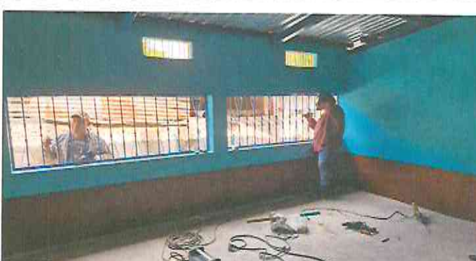
Foto 6: Instalación de balcones en ventanas de 2.00x1.00mts
