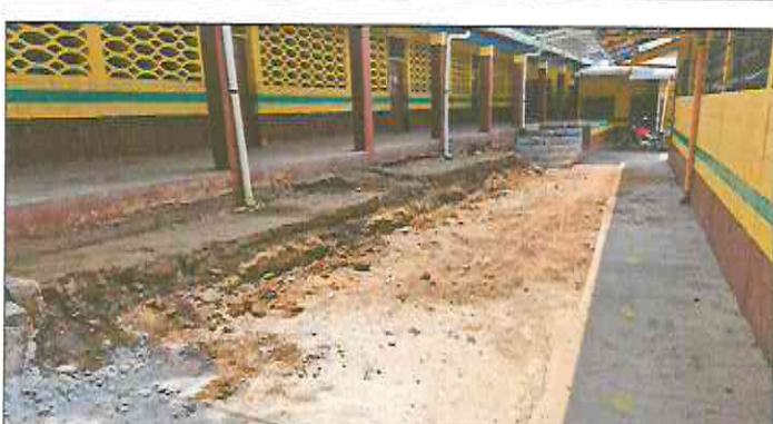
Foto 6: Construcción gradas en escenario.
