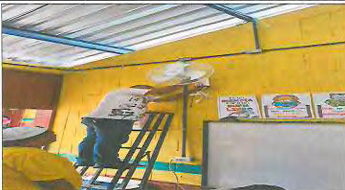
Foto 2: Sustitución de ventiladores.
