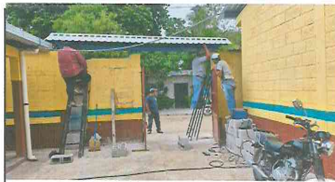
Foto 6: Sustitución de portón de ingreso de 2.5m x 4.00m y techado en área de portón con costanera + lamina troquelada aluzinc cal. 26.
