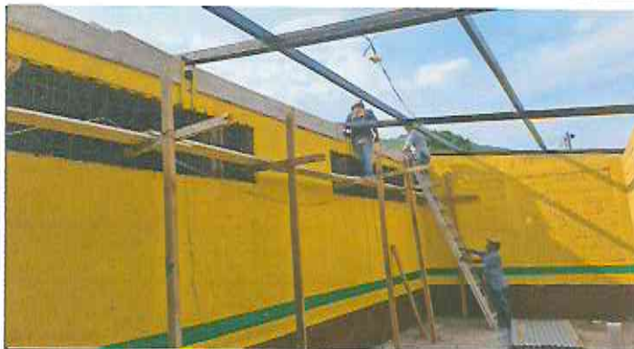
Foto 3: Levantado de hiladas de block.
