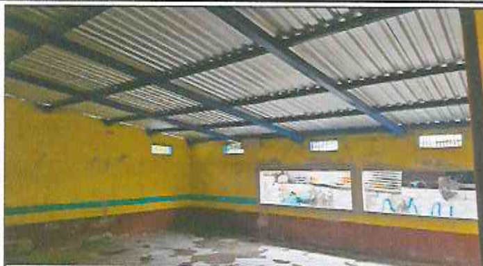
Foto 1: Instalación de lámina troquelada aluzinc cal. 26.
