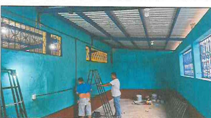
Foto 6: Reparación eléctrica iluminación y fuerza.
