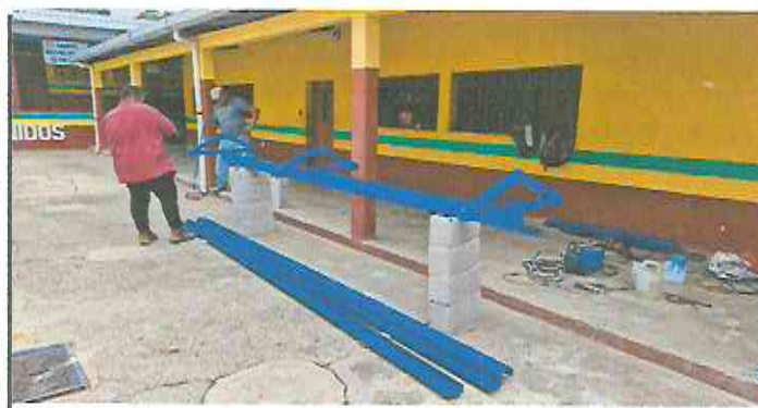
Foto 5: Sustitución de portón de ingreso de 2.5m x 4.00m y techado en área de portón con costanera + lamina troquelada aluzinc cal. 26.
