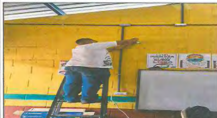
Foto 3: Sustitución de ventiladores.
