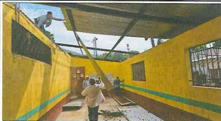
Foto 1: Retiro de lámina existente.
