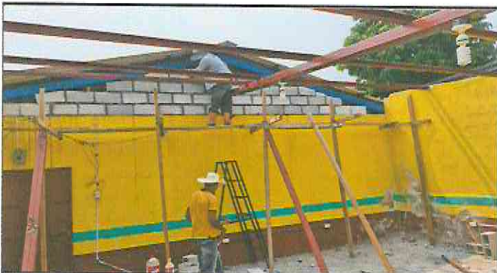
Foto 3: Levantado de hiladas de block.
