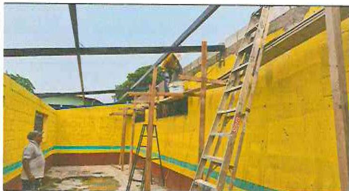
Foto 3: Levantado de hiladas de block.
