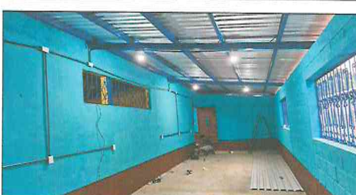
Foto 6: Reparación eléctrica iluminación y fuerza.
