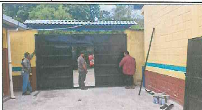
Foto 2: Sustitución de portón de ingreso de 2.5m x 4.00m y techado en área de portón con costanera + lámina troquelada aluzinc cal. 26.
