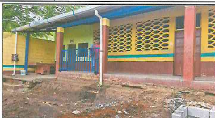
Foto 2: Instalación de baranda metálica en corredor.
