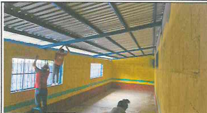
Foto 1: Instalación de lámina troquelada aluzinc cal. 26.
