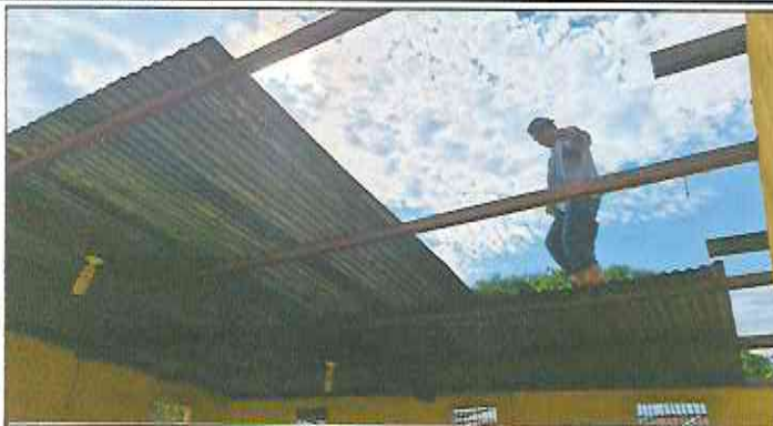
Foto 1: Instalación de lámina troquelada aluzinc cal. 26.
