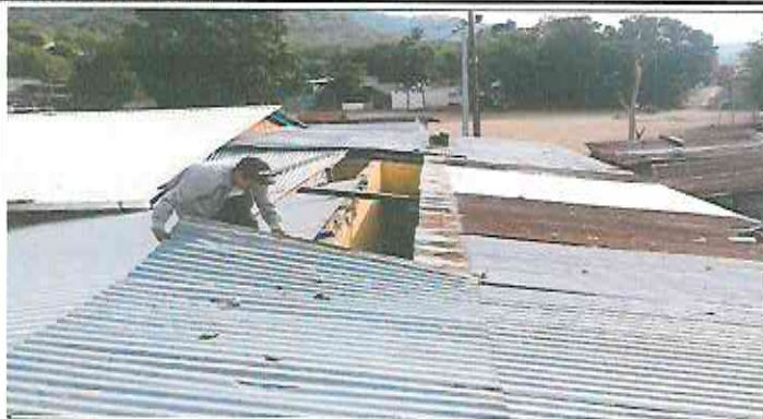
Foto 1: Retiro de lámina existente.
