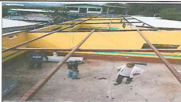
Foto 2: Retiro de lámina existente.
