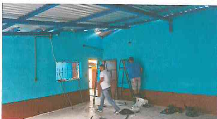
Foto 4: Reparación eléctrica iluminación y fuerza.
