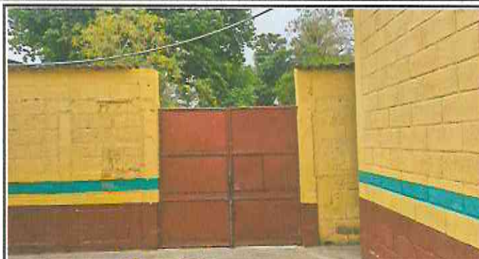
Foto2: Sustrucción de portón de ingreso de 2.5m x 4.00m y techado en área de portón con costanera + lamina troquelada aluzinc cal. 26.
