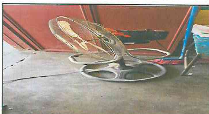
Foto4: Sustitución de ventiladores.
