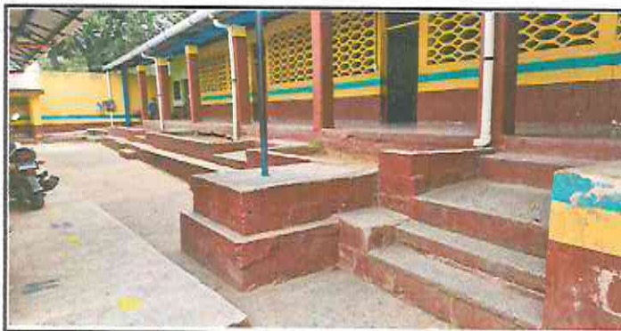
Foto5: Construcción gradas en escenario, instalación de baranda metálica en corredor, pintura en escenario, construcción de gradas de acceso al corredor y banqueta.
