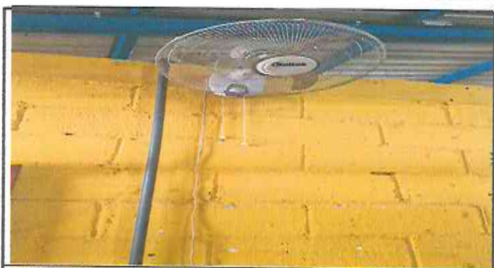
Foto5: Sustitución de ventiladores.
