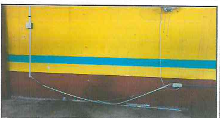
Foto6: Reparación eléctrica iluminación y fuerza,
