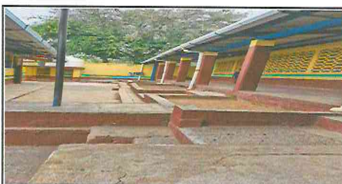
Foto6: Construcción gradas en escenario, instalación de baranda metálica en corredor, pintura en escenario, construcción de gradas de acceso al corredor y banqueta.
