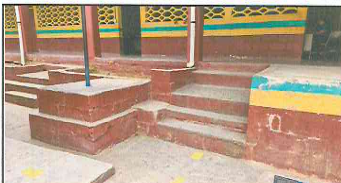
Foto4: Construcción gradas en escenario, instalación de baranda metálica en corredor, pintura en escenario, construcción de gradas de acceso al corredor y banqueta.
