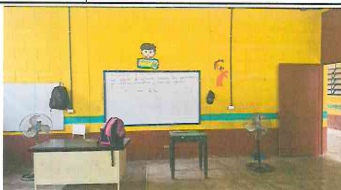
Foto2: Sustitución de ventiladores.
