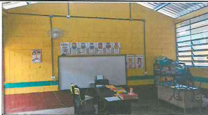
Foto1: Sustitución de ventiladores.
