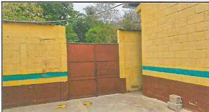
Foto1: Sustrucción de portón de ingreso de 2.5m x 4.00m y techado en área de portón con costanera + lamina troquelada aluzinc cal. 26.
