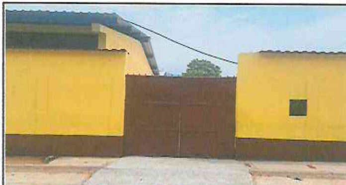
Foto3: Sustrucción de portón de ingreso de 2.5m x 4.00m y techado en área de portón con costanera + lamina troquelada aluzinc cal. 26.
