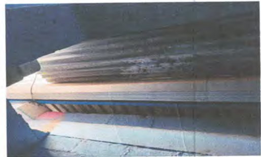
Foto 6: INSTALACIÓN DE TERRAZA
