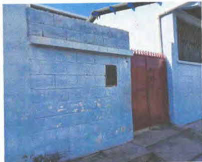
FOTO 7: DEMOLER PARED DE BLOCK EN ENTRADA PRINCIPAL ✓
