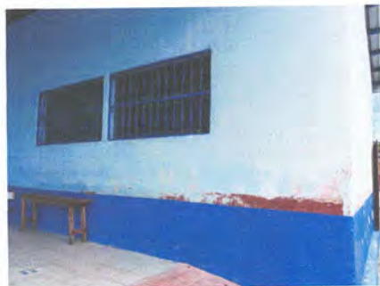
FOTO 10: PINTURA DE MUROS EXTERIORES E INTERIORES ✓
