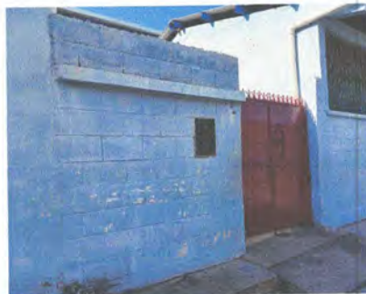
FOTO 8: SUSTITUCIÓN DE PORTÓN CORREDIZO CON PUERTA INCORPORADA MIDE ALTO 2.4 MTS. U LARGO 4.10 MTS
