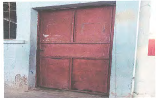
Foto 4: SUSTITUCIÓN DE PUERTA D EMETAL DE 2 MTS. DE ALTO POR 1 MTS. DE ANCHO
