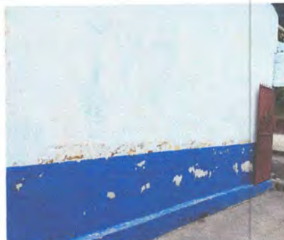
FOTO 11: PINTURA DE MUROS EXTERIORES E INTERIORES ✓
