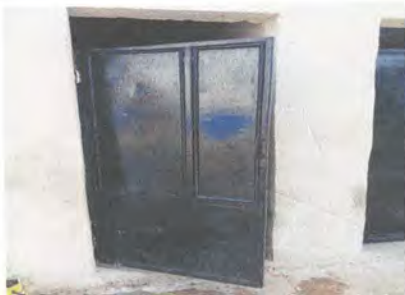
Foto 5: MANTENIMIENTO DE PUERTA (LIJADO Y PINTURA)
