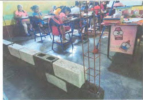
Foto 6: levantado de hiladas de block y repello en muro aula 2
