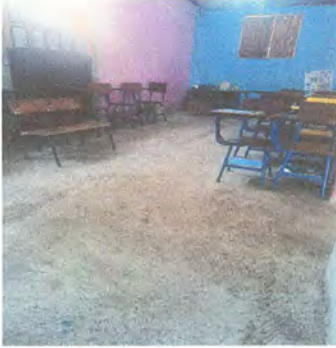
Foto 1: Sustitución de piso aula 1
