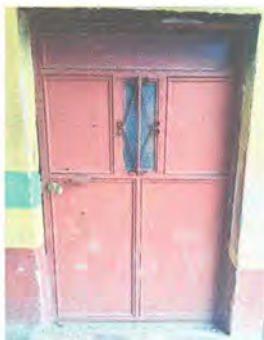
Foto 13: Sustitución de puerta cocina.
