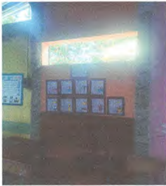
Foto 3: Repello de muro aula 1
