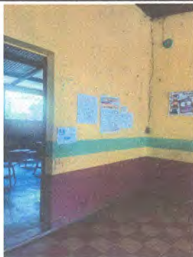
Foto 7: cortado, tallado y colocación de puerta aula 2
