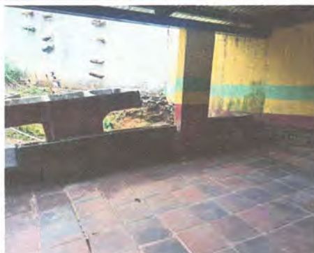
Foto 14: sustitución de piso cocina
