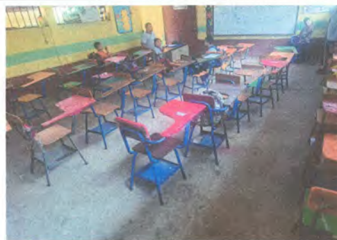
Foto 12: colocación de piso cerámico aula 3
