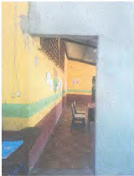
Foto 5: colocación de puerta de metal aula 1
