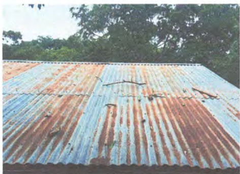
Foto 9: sustitución de techo cocina
