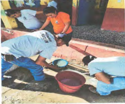
Foto1: SUSTITUCIÓN DE TUBERÍA PVC 100 PSI DE 4 PULGADAS CON SU RESPECTIVA CAJA
