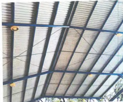
FOTO 8: INSTALACIÓN ELECTRICA ILUMINACIÓN Y FUERZA (CABLE, TOMACORRIENTES, APAGADORES Y LAMPARAS)
