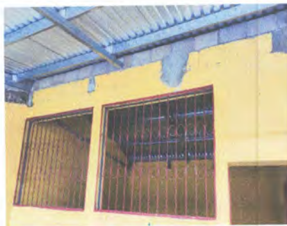
FOTO 12: MANTENIMIENTO DE BALCONES (LIJADO, CEPILLO Y PINTURA)
