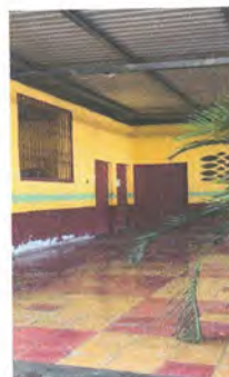
FOTO 10: MANTENIMIENTO DE PUERTAS (LIJADO, CEPILLADO Y PINTURA)
