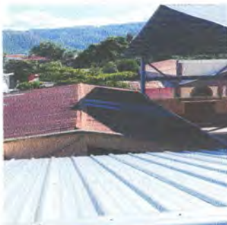
FOTO 21: SUSTITUCIÓN DE LAMINA POR LAMINA TROQUELADA ALUZINC CALIBRE 26
