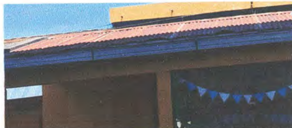
Foto 2: RETIRO DE LAMINA EXISTENTE
