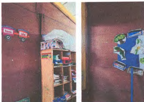
FOTO 9: REPELLOY CERNIDO EN LA PARED QUE SE SUSTITUYE DEBIDO A QUE SOSTIENE CON ANAQUELES
