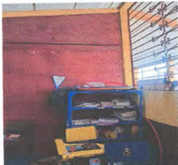
FOTO 13: SOSTENIDO CON ANAQUEL LA PARED DE MADERA
