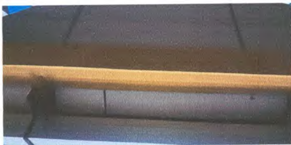
Foto 3: DESISTALACIÓN DE ESTRUCTURA DE SOPORTE DE MADERA
