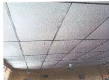
Foto 6: DESISTALACIÓN DE CIELO FALSO
