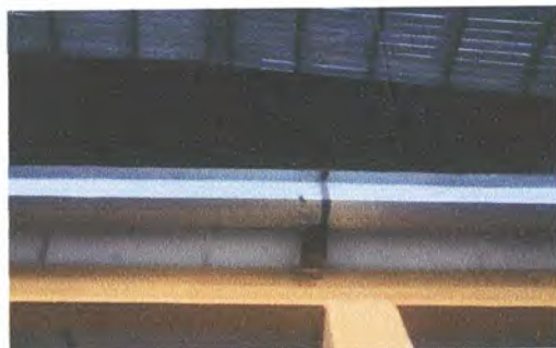
Foto 5: SUSTITUCIÓN DE CANAL DE METAL
