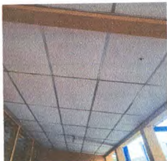
FOTO 7: REINSTALACIÓN DE CIELO FALSO
