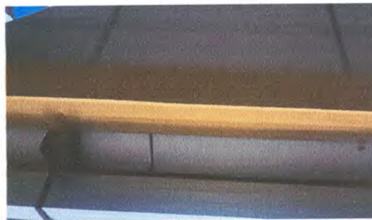
Foto 4: SUSTITUCIÓN DE ESTRUCTURA DE MADERA POR METAL
