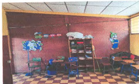
FOTO 8: SUSTITUCIÓN DE PARED DE MADERA POR PARED DE BLOK
