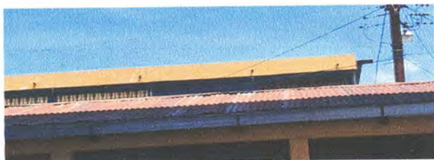
Foto 1: SUSTITUCIÓN DE LAMINA POR LAMINA TROQUELADA ALUZINC CALIBRE 26
