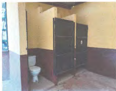
FOTO 3: REEMPLAZO DE ACCESORIOS DE SANITARIOS
