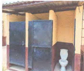
FOTO 4: MANTENIMIENTO DE PUERTAS EXISTENTES
