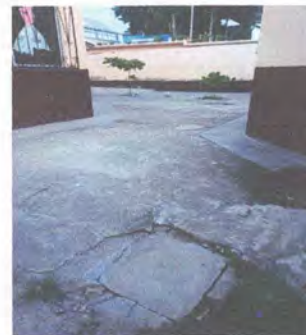
FOTO 12: SUSTITUCIÓN DE PISO EN PATIO
