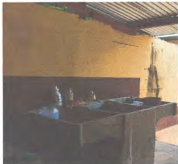
FOTO 1: ELABORACIÓN DE PILA DE 1X2 CON AZULEJO
