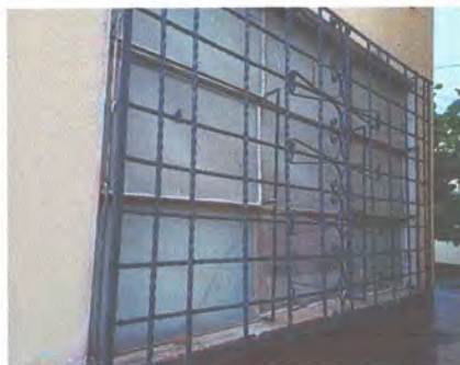
FOTO 14: PINTURA DE BALCONES
