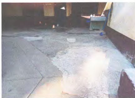
FOTO 11: SUSTITUCION DE PISO DE CONCRETO DE PASILLO
