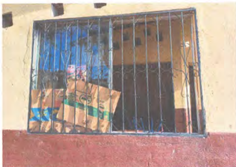
FOTO 9: SUSTITUCIÓN DE VENTANA AULA 3 3.00 M2
