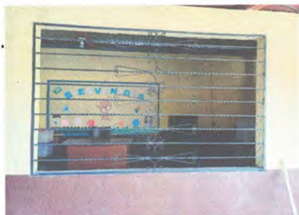
FOTO 5: COLOCACIÓN DE VENTANA PVC
