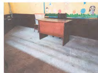
FOTO 6: COLOCACIÓN DE PISO CERÁMICO
