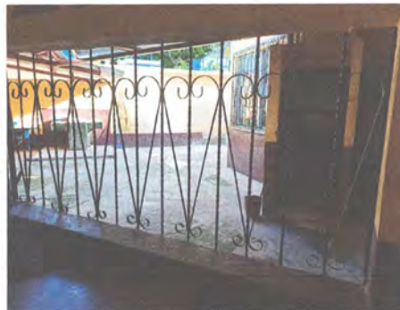
FOTO 8: COLOCACIÓN DE VENTANA AULA 1 1.89 M2
