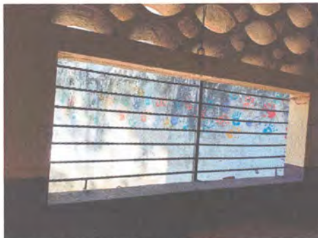
FOTO 7: COLACIÓN DE VENTANA PVC AULA 1 1.48 M2
