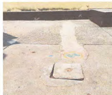
FOTO 2: SUSUTITUCION DE CONCRETO EN TUBERIA DE AGUAS NEGRAS
