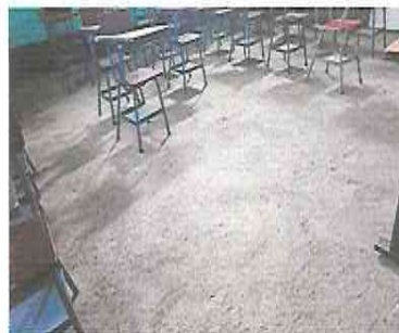
FOTO 2: INSTALACION PISO CERAMICO EN MODULO 2
