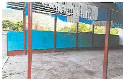
FOTO 5: FUNDICION PISO CONCRETO EN MODULO 2
