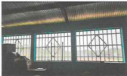
FOTO 3: COLOCACIÓN DE VENTANA PVC
