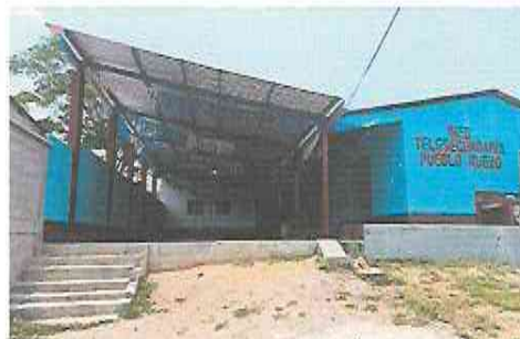
FOTO 6: REPARACIÓN DE GRADAS DE INGRESO
