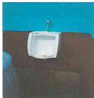
FOTO 10: SUSTITUCION E INSTALACION DE MINGITORIO
