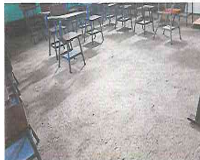
FOTO 8: COLOCACIÓN DE PISO CERÁMICO
