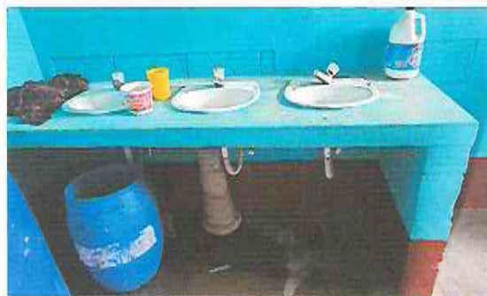
FOTO 9: SUSTITUCION DE ACCESORIOS EN LAVAMANOS
