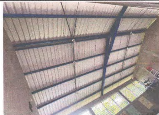
Foto 10: Fabricación e instalación de cielo falso en modulo de aula 3
