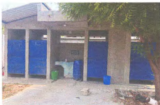
Foto 3: Pintura de puertas de baños
