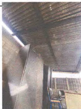
Foto 6: Sustitución de lámina por lámina y estructura de soporte metal (costanera) en módulo de dirección.
