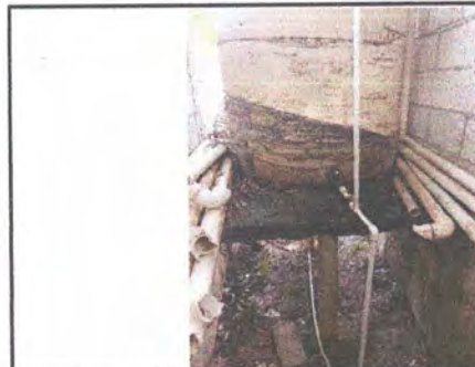
SUMINISTRO E INSTALACION DE BOMBA HIDRONEUMATICA DE 1/2 HP CON TANQUE DE 25 LITROS EN TINACO EXISTENTE, SE NECESITA LA INSTALACION DEL EQUIPO PORQUE LA PRESION DEL AGUA NO LLEGA HASTA EL AREA DE SANITARIOS Y PILA Y A LOS NIÑOS LES TOCA IR AL TANQUE DE AGUA A JALAR AGUA PARA EL BAÑO.
