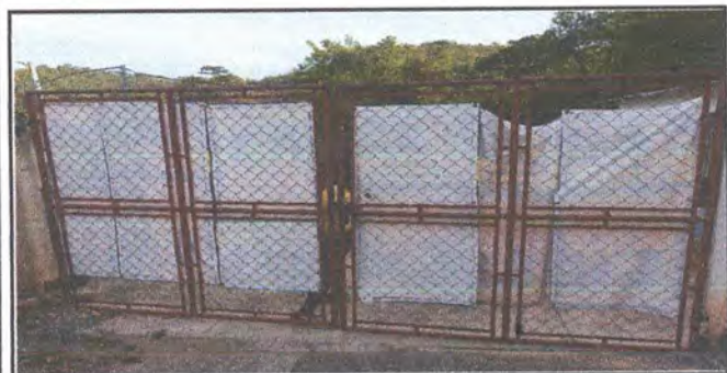
REPARACION DE PORTON DE ENTRADA PRINCIPAL, SUSTITUCION DE MALLA POR LAMINA 3/64 CON DISEÑO TROQUELADO MEDIDA DE 4.05 X 2.15 METROS
