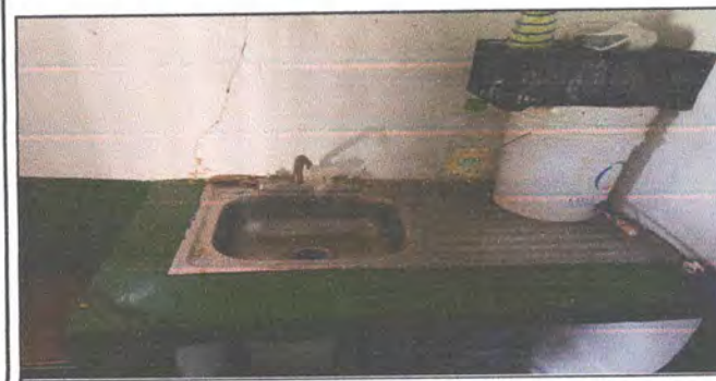
SUMINISTRO E INSTALACION DE LAVATRASTOS DE ACERO INOXIDABLE EN AREA INTERIOR DE AULAS EN ESPACIO ACOMODADO PARA COCINA
