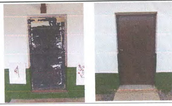
MANTENIMIENTO A PUERTAS DE METAL ( LIJADO Y PINTADO)
