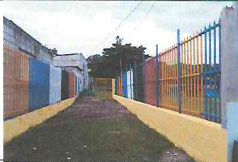
Foto 1: 1.1 FABRICACION E INSTALACION DE BARANDA DE METAL
