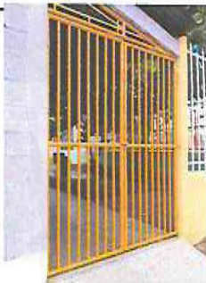
Foto 3: 1.2 REPARACION DE PORTONES
