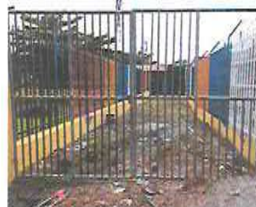
Foto 4: 1.2 REPARACION DE PORTONES DE INGRESO
