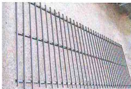
Foto 1: 1.1 SUSTITUCION DE MALLA, POR BARANDA DE METAL CIN TUBO CUADRADO DE 1" CHAPA 18
