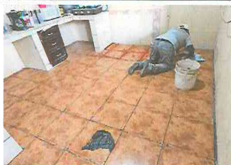
Foto 3: SUSTITUCION DE PISO DE CONCRETO POR CERAMICO
