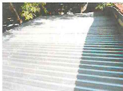
Foto 2: SUSTITUCION DE LAMINA POR LAMINA TROQUELADA ALUZINC CALIBRE 26
