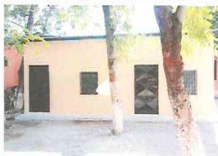
Foto 5: MANTENIMIENTO DE ESTRUCTURA (LIJADO, CAMBIO DE TUBO, CEPILLADO Y APLICACIÓN DE PINTURA)
