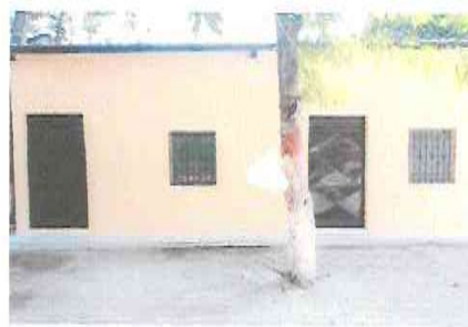
Foto 6: SUSTITUCIÓN DE 21 METROS DE PARED DE BLOCK
