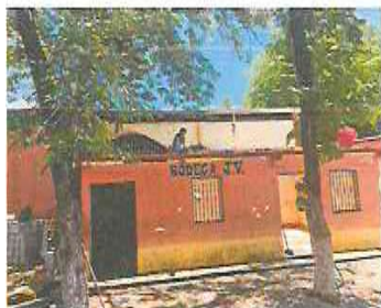
Foto1: MANTENIMIENTO DE ESTRUCTURA DE TECHO
