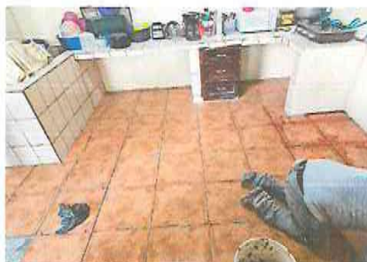
Foto 3: SUSTITUCION DE PISO DE CONCRETO POR CERAMICO
