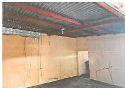
Foto 2: SUSTITUCION DE LAMINA POR LAMINA TROQUELADA ALUZINC CALIBRE 26
