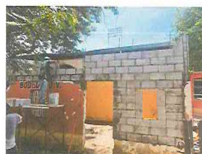
Foto 6: SUSTITUCIÓN DE 21 METROS DE PARED DE BLOCK
