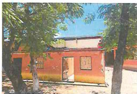
Foto 5: MANTENIMIENTO DE ESTRUCTURA (LIJADO, CAMBIO DE TUBO, CEPILLADO Y APLICACIÓN DE PINTURA
