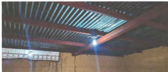
Foto 2: Sustitucion de lamina por lamina troquelada aluzinc calibre 26
