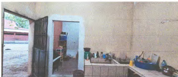
Foto 4: Pintura en muros exteriores e interiores
