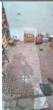
Foto 3: Sustitucion de piso de Concreto a ceramico
