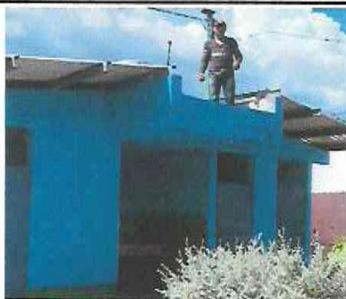
11.1 Sustitución de accesorios de deposito de agua
