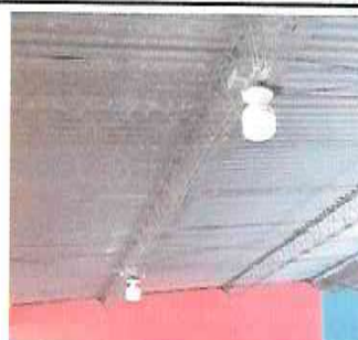
10.1 Sustitución de lampara modulo de aula #1
