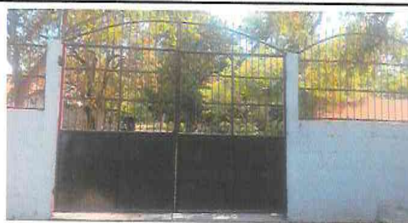
8.1 Mantenimiento a portón de metal
