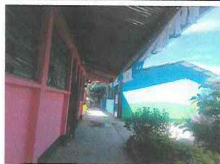
6.1 Pintura a muros interiores y exteriores
