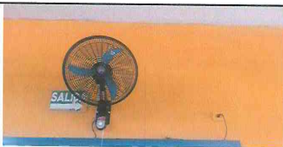
7.1 Sustitución de ventiladores en modulo de aula #2
