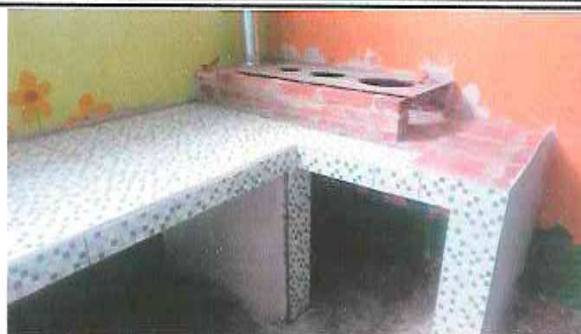
12.1 y 12.2 Sustitución de estufa rural y mueble de concreto y azulejo para alimentos
