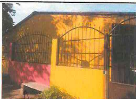
9.1 Baranda sobre muro perimetral
