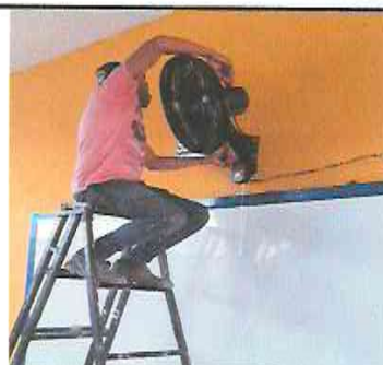
7.1 Sustitución de ventiladores en modulo de aula #2
