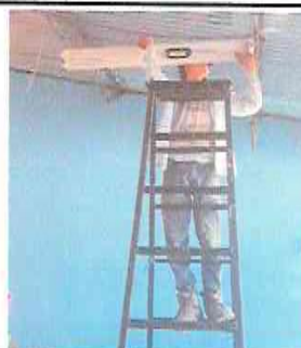
10.1 Sustitución de lampara modulo de aula #1
