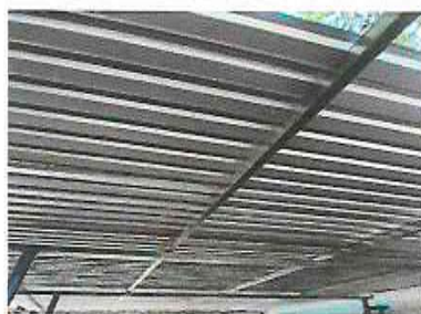
1.1 Sustitución de lamina por lamina troquelada aluzinc
