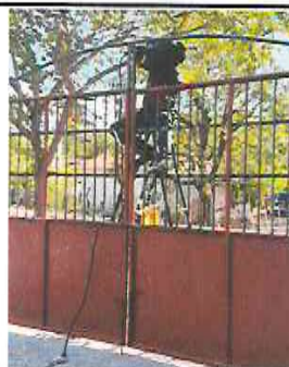
8.1 Mantenimiento a portón de metal
