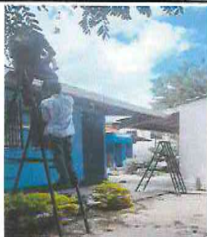
5.1 y 5.2 Sustitución de Canal y Bajada de Agua pluvial
