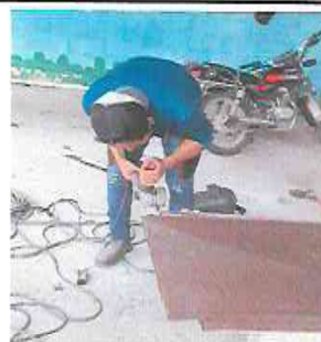
3.2 Sustitución de puerta a servicio sanitario
