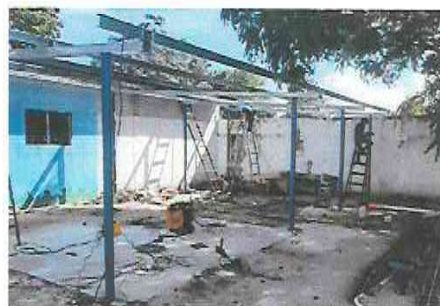
2.1 Sustitución de estructura soporte metal por metal
