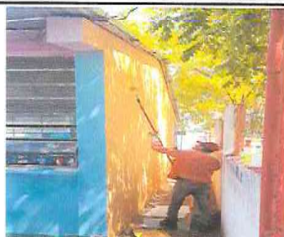
6.1 Pintura a muros interiores y exteriores
