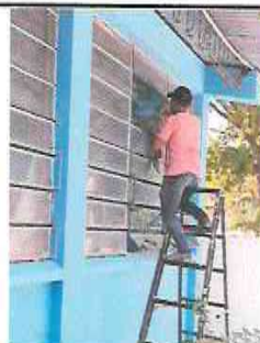
4.1 Sustitución de vidrios
