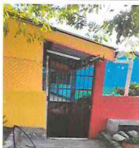
3.3 Sustitución de puerta de ingreso
