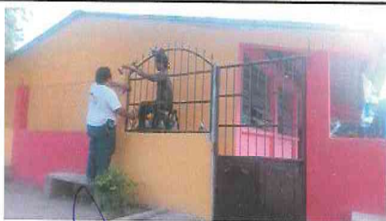
9.1 Baranda sobre muro perimetral
