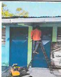
3.1 Mantenimiento a puertas de metal
